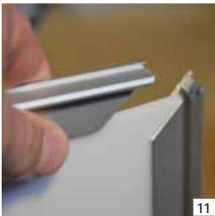
Setzen Sie umlaufend die „U“-Winkel auf die 4 Seiten der Acrylglasplatte.
