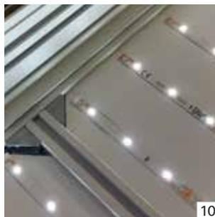
Bei geteilter Rückwand müssen die Ecken die am Aussteifungsprofil angrenzen, abgeschnitten werden (ca. 20 x 20mm schräg).
