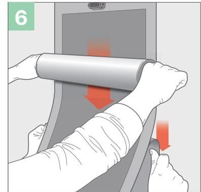
Wiederholen Sie Schritt 6, bis die Solarfolie vollständig fixiert ist. Achten Sie darauf, dass die Silikonrolle immer den ersten Kontakt der Solarfolie mit der Oberfläche herstellt. Vergewissern Sie sich, dass die Solarfolie gleichmäßig auf der Oberfläche fixiert ist, indem Sie die Silikonrolle über die gesamte Breite bewegen.
